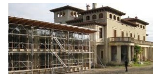
Université catalane d'été de Prades Yves Jautard Architectes
