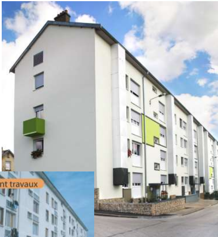
Rénovation BBC SA Doloise, Dole
