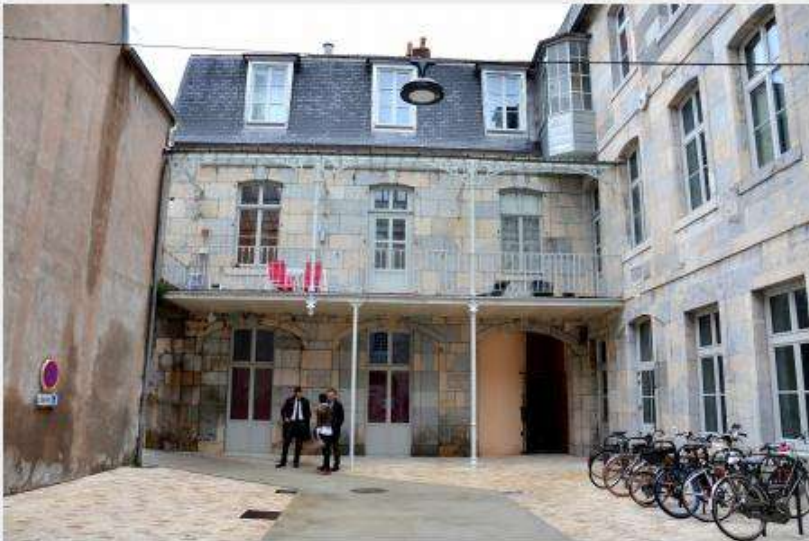
Rénovation BBC SAIEMB Logement, Besançon
