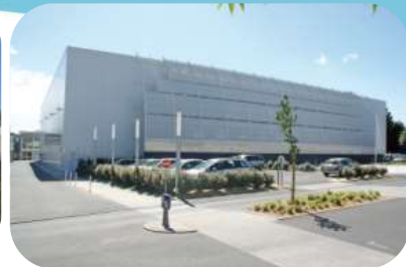
Centre Municipal des Sports à Châteaubriant : Réhabilitation énergétique
