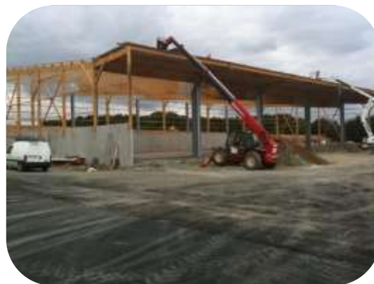
Plate-forme Biomasse à Nozay
