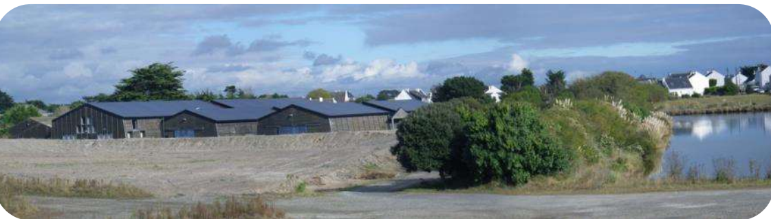
Ferme solaire : 800 m 2 de capteurs portés par LAD-SELA
