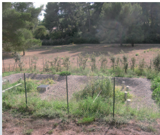
Le système d'assainissement : la filtration des eaux par lit planté de roseaux
