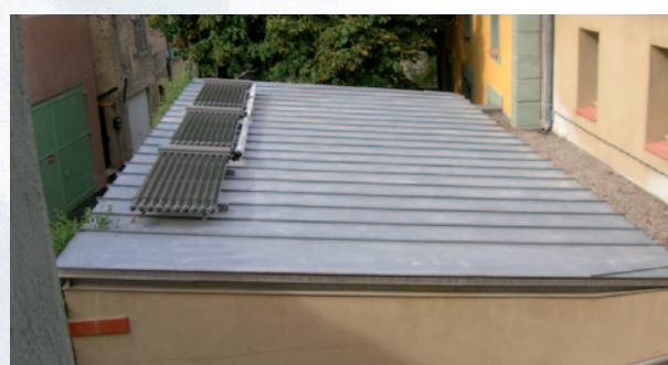
Eau chaude avec panneaux solaires
