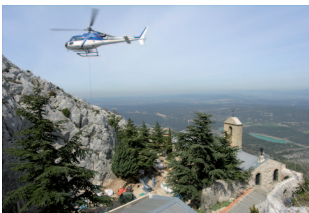
Hélicoptage des matériaux
