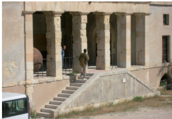
Bâtiment Saint Roch (mis hors danger)
