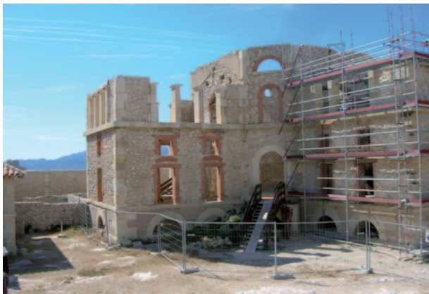
Aile du Chevalier Roze (restauration en cours)
