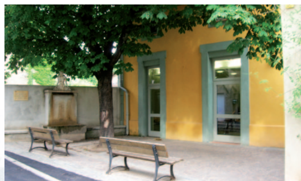
Enduits à la chaux
