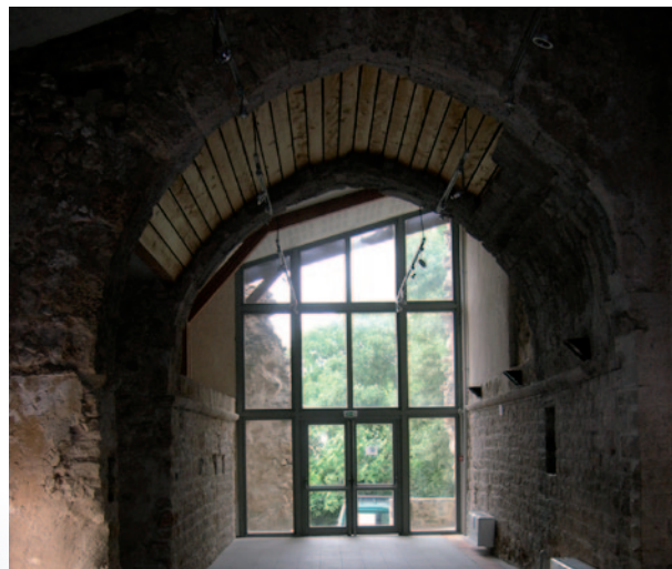
Aménagement avec de nouveaux matériaux. Utilisation de menuiseries métalliques (Château Gibron commune de Correns - Var)
