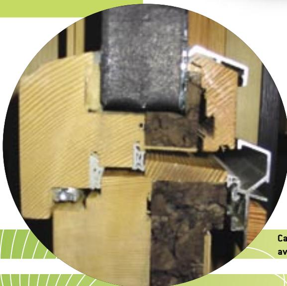
Cadre de fenêtre en bois avec isolation renforcée en liège
