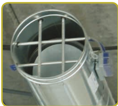
Ailes de mesure, avec détail des deux prises de pressions à droite
