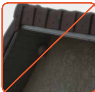
La sonde est dans un renforcement où la température est différente ; le rayonnement solaire est réfléchi par la toiture en-dessous
