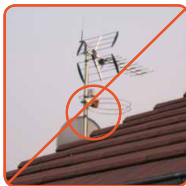
La sonde est à plat, mais elle est soumise au masque créé par l'antenne
