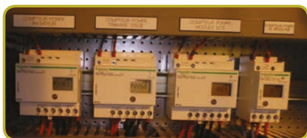
Compteurs électriques sur rails DIN, explicitement libellés
