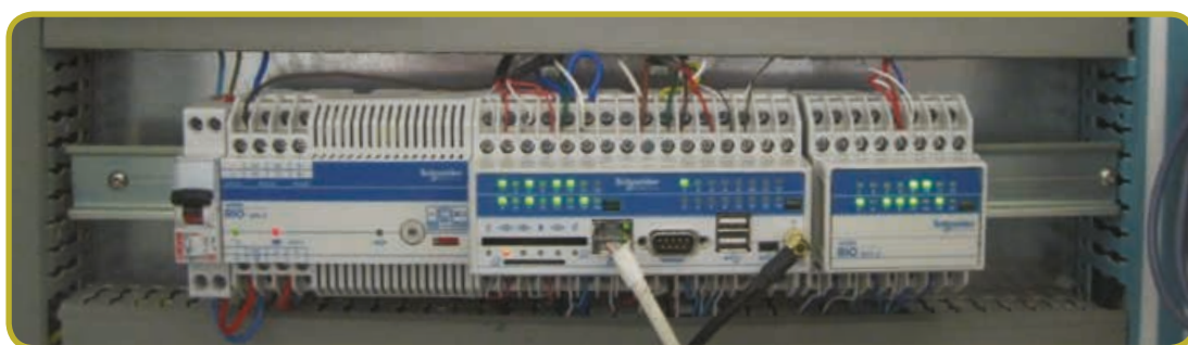
Centrale d'acquisition avec module d'alimentation, module de communication et d'entrées / sorties principal et module d'extension
