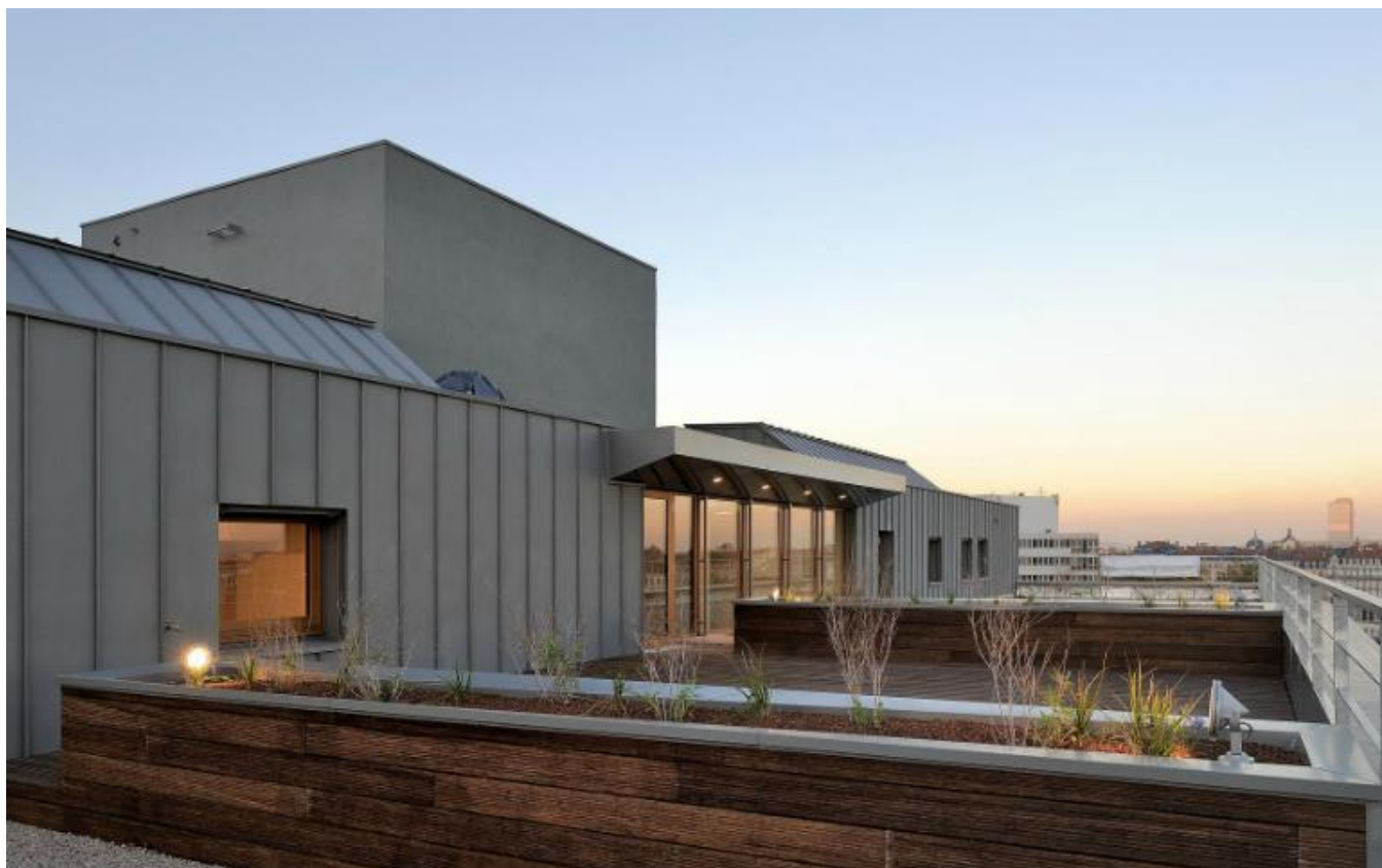
Figure 1 : Rénovation – Quai des Etroits - CIRMAD
