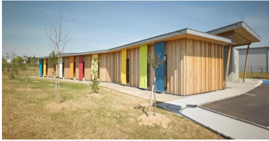
Figure 16 : Bâtiment Effinergie+ - MO : AIST 87 – Bureaux – Spirale Nicolas Balmy – Saint Junien
