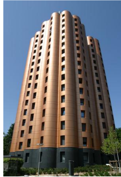
Figure 2 Bâtiment BBC-Effinergie rénovation – La Tour des Jeunes Mariés – MO : France Habitation - Crédits photos : Thomas APPERT
