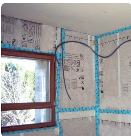
Jointement de chaque laize de pare-vapeur Photo : DER
