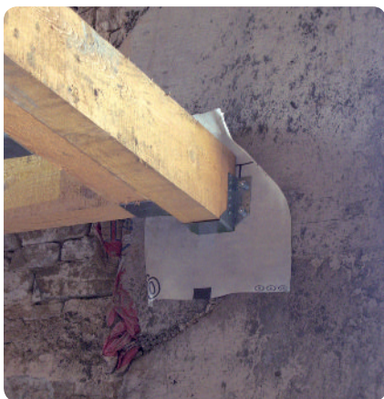
Réfection de plancher intermédiaire : Pose d'un morceau de membrane d'étanchéité entre le sabot et le mur pour faciliter le raccordement ultérieur à la membrane en partie courante.
