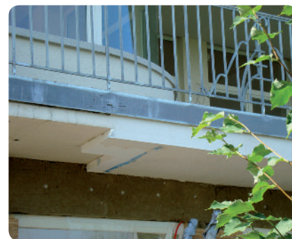
Exemple de traitement thermique d'un balcon Photo : Pouget Consultants
