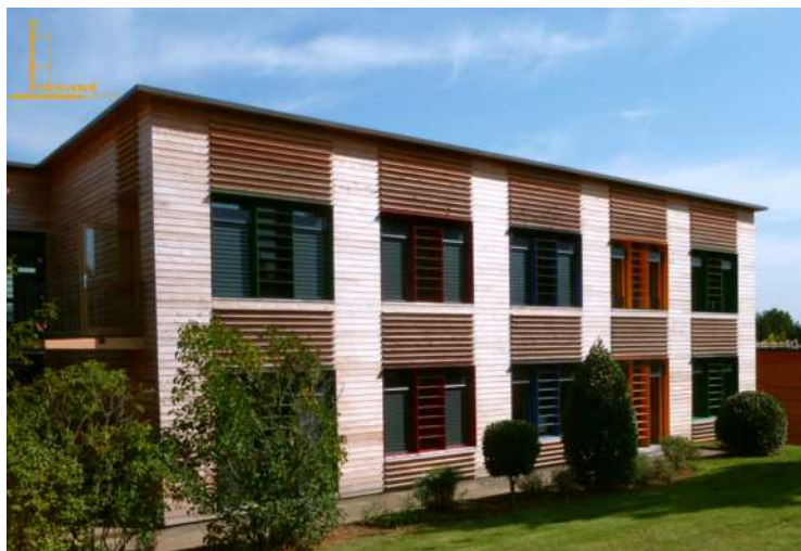
Photos 9- Exemple de traitement architectural d'encadrements de baies / rénovation du groupe scolaire du Grégoire à Dardilly (69)
