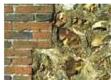
L'épaisseur et l'aspect des briques sont variables selon l'époque de construction du bâtiment. A la brique manuelle succède peu à peu, à partir du XIXe siècle, la brique mécanique. Enfin, la brique et la pierre pouvaient être utilisées pour le remplissage de murs à pan de bois.
