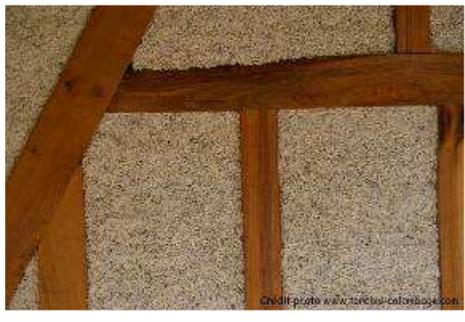
Isolation faite avec du béton de chanvre
