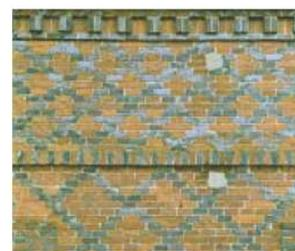
On trouve également des maçonneries mixtes qui regroupent sur un même bâtiment différents types de briques. Le silex, associé à la brique, est largement utilisé dans les maçonneries. On en tire parfois un parti décoratif en laissant affleurer ses cassures brillantes.
