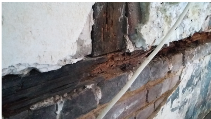
Figure 4 : Illustration des enjeux techniques associés aux risques de pathologie après réhabilitation énergétique – Pourriture du bois observée après dépose d'un isolant
