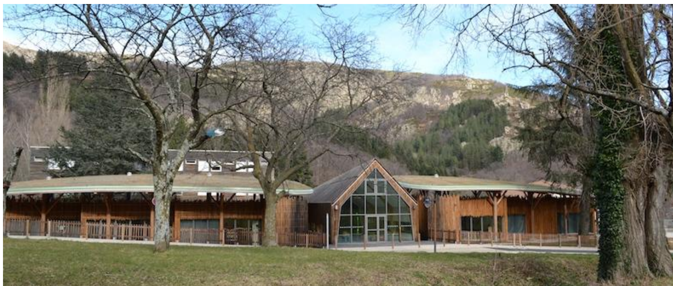
Figure 6 : Groupe Scolaire – Montpézat sur Bauzon - Source : Observatoire BBC Rhône Alpes (Architecte Vision)
