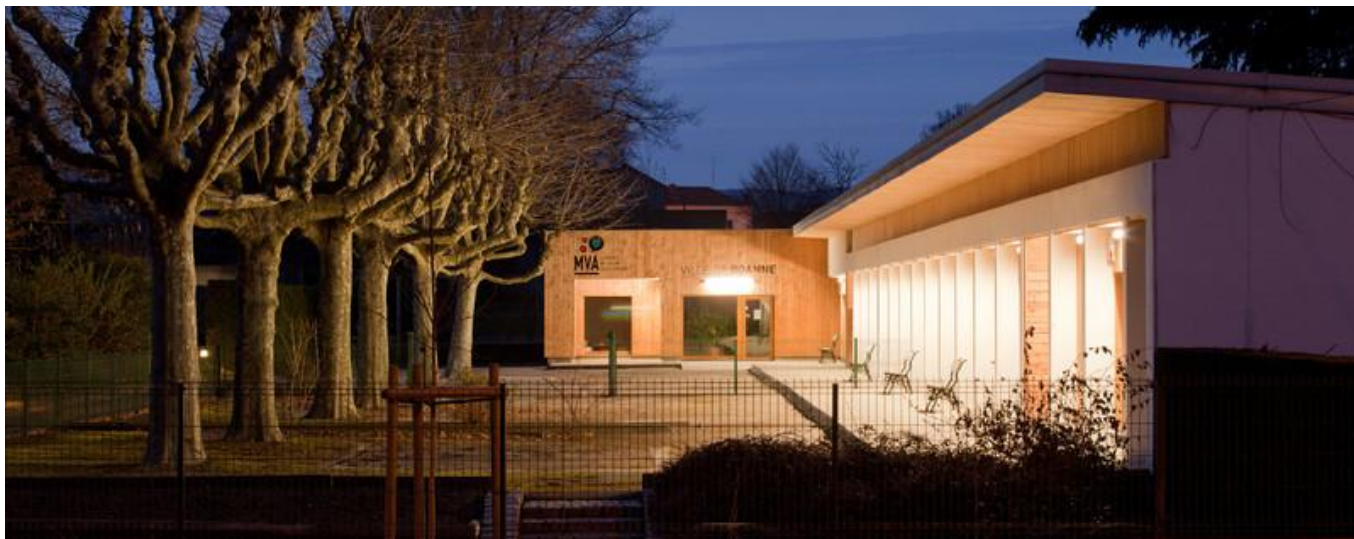
Figure 2 : Maison de la vie associative - Roanne - Source : Observatoire BBC Rhône-Alpes (Fabriques Architectures Paysages)
