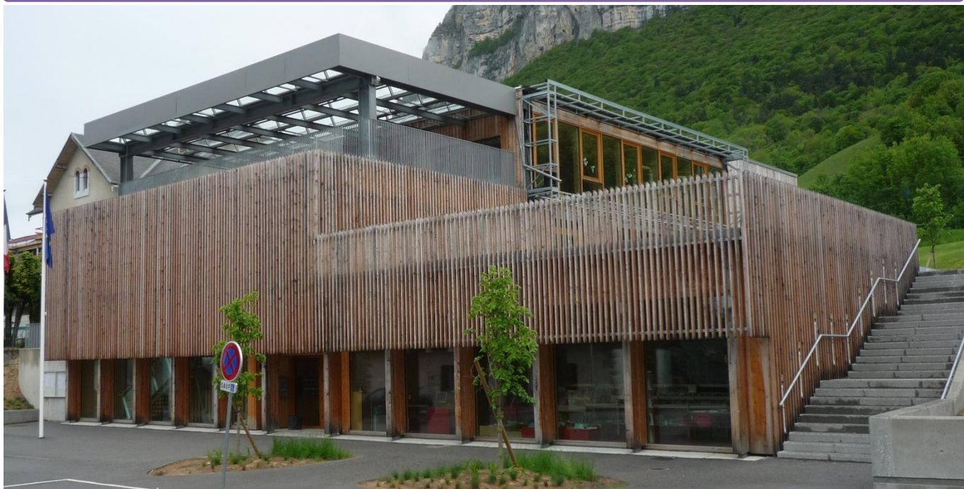
Figure 13 : Bâtiment multifonctionnel – Saint Jean d'Arvey - Source : Observatoire Rhône-Alpes (Vincent Rocques Architecte)
