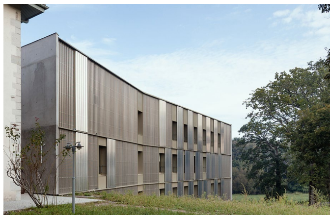
Figure 12 : Extension du siège de la MACS – Bepos Effinergie 2013 – Saint Vincent de Tyrosse – Architecte : Agence Patrick Arotcharen – MO : Centre intercommunal d'action sociale de la MACS
