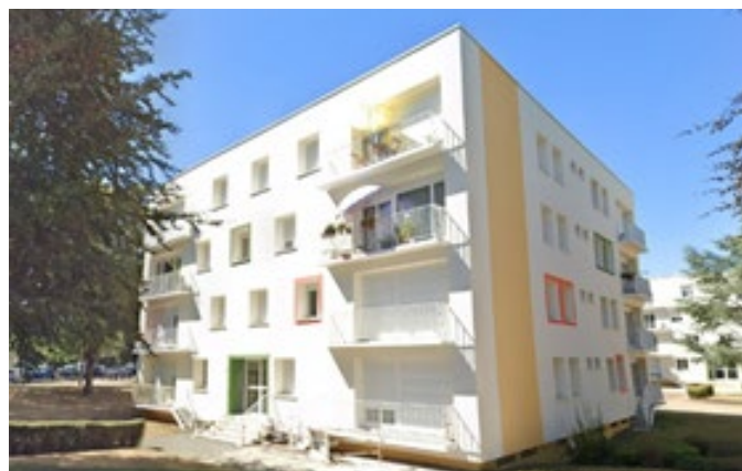
Figure 21 : Rénovation BBC-Effinergie– Résidence Roger Poulin – MO : SNI Plaine Normande
