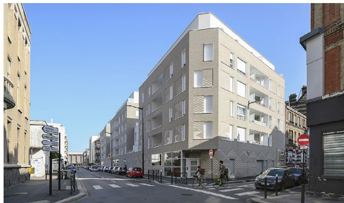
Figure 17 : Résidence Jule Lescene - Effinergie+ - MO : Habitat 76 – Architecte : Atelier Bettinger Desplanques Architectes – Nanterre
