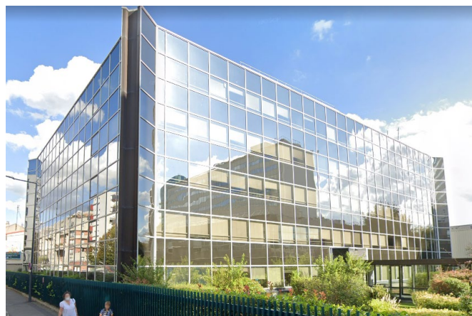
Figure 27 : Rénovation Bureau Welcome Inside – BBC Effinergie Rénovation - MO : SNC Montreuil République – Architecte : DY Architecte – Montreuil
