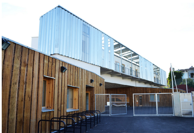
Centre Animation d'Argonne | Architecte : Dauphins Architecture – Bordeaux
