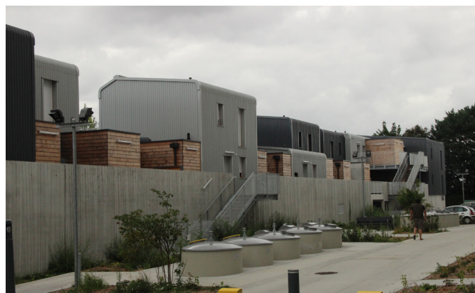
Opération Mussonville Secteur B | Architecte : Agence Cécile Moga | MO : ICF Habitat Atlantique – Bègles
