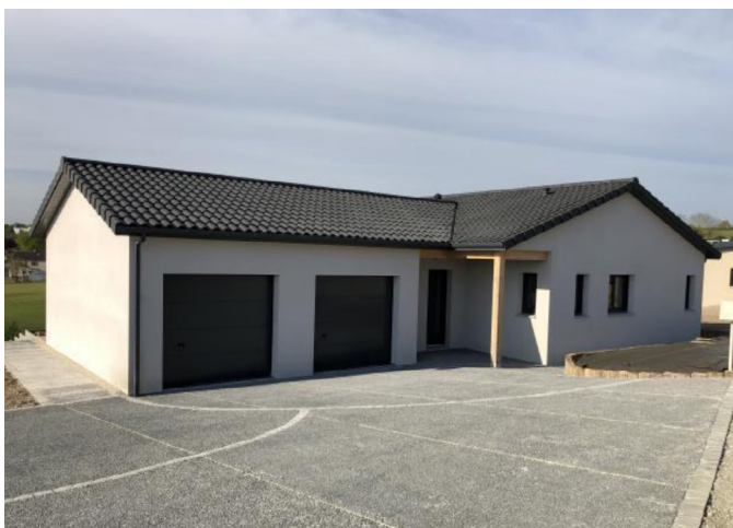
Maison P. | EMA Construction - Bressuire
