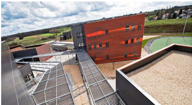
Internat CFA BTP Charente | Architecte : L2 Architectes et Poirier-Bordage – Chasseneuil sur Bonnieure
