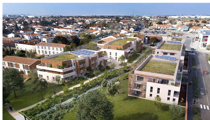
Résidence Le Clos du Coudray | Architecte : Cointet Associé | MO : OPH de la Rochelle – Périgny
