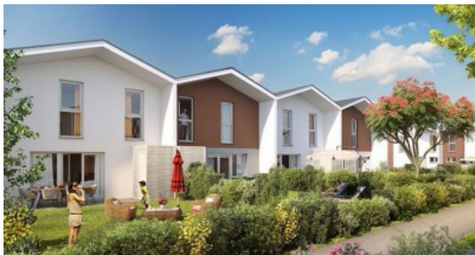
Résidence Oreka | Bepos Effinergie 2017- Bayonne
