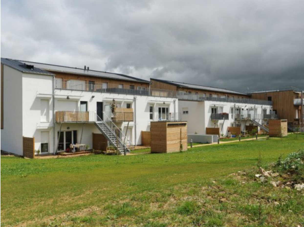
Résidence Esperia - BEpos Effinergie © Matières d'espace architectes
