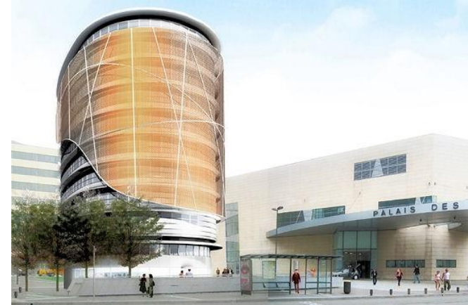
Captation des renouvelables
